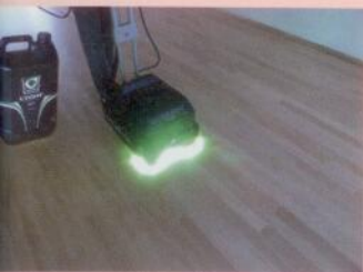
De nieuwe parketlak van Ursa Paint hardt uit door gebruik van een UV-lamp
